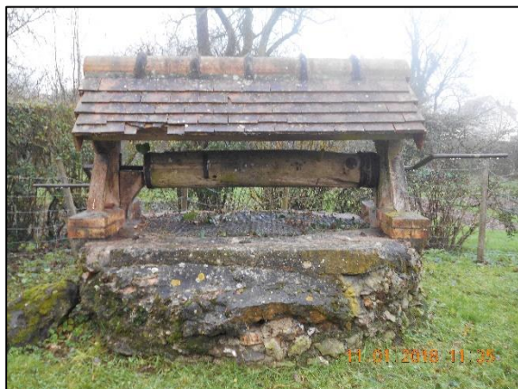
Puits des Hautes Lisières
