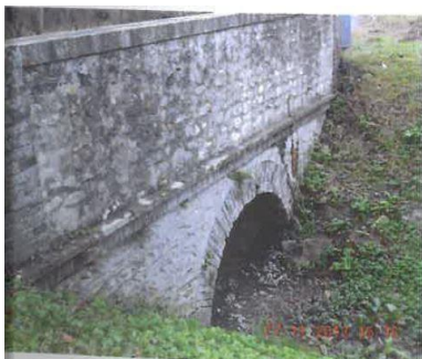
Pont de Rondeville
